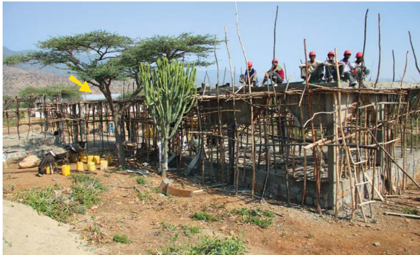
Gerüstbau auf äthiopische Art: die Baustelle des Wohnhauses für die Ärzte, im Hintergrund (Pfeil) die unfertigen staatlichen Gebäude
