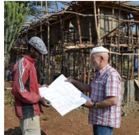
Baukontrolle mit Bauleiter Tsehaye
