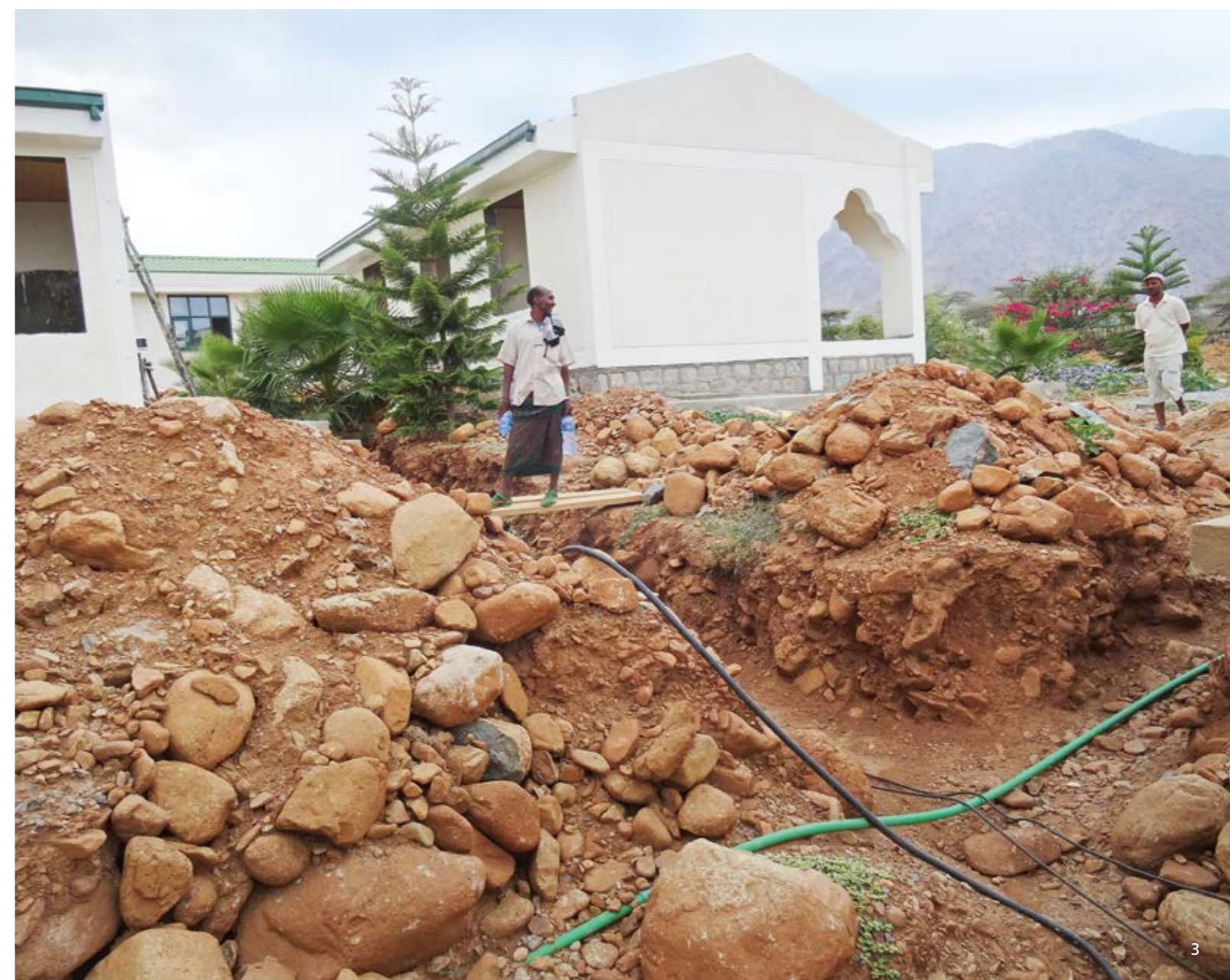
Alles in Handarbeit: unsere Baustelle mitten in der Danakilwüste
